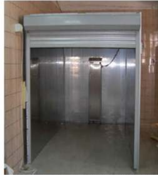
Resim 2.32: Asansör kapılı buhar odası
